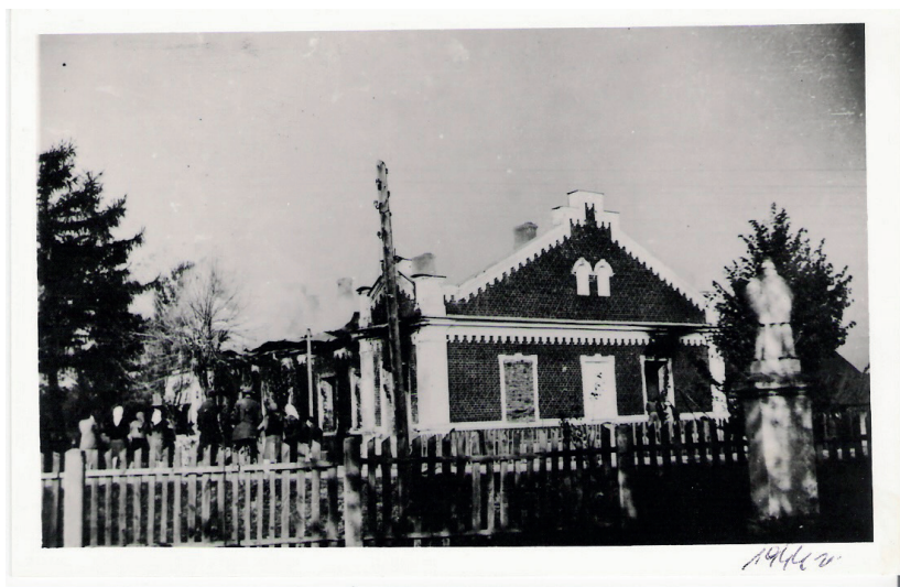
Październik 1943 r. Budynek posterunku żandarmerii niemiecko-ukraińskiej w Łukowej bezpośrednio po jego likwidacji. Obecnie jest to siedziba Urzędu Gminy Łukowa. Źródło: zbiory GOK w Łukowej .
